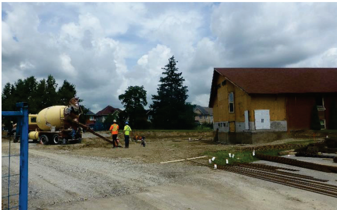
Pouring the cement
